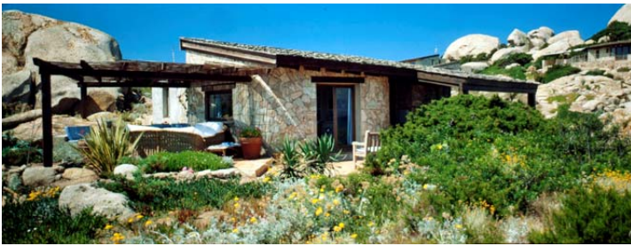
1988 Arch. Roques, Macciò
